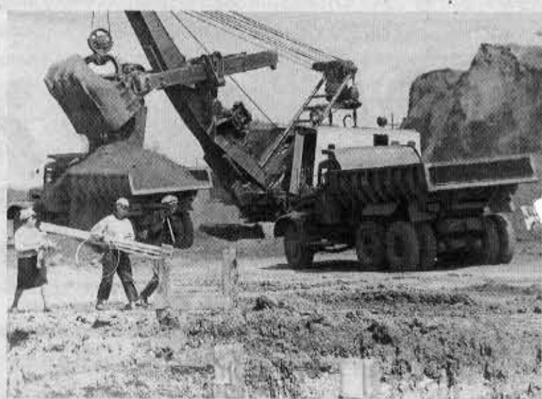
Начало земляных работ.
